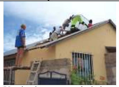
Vandtanken sættes på plads.
